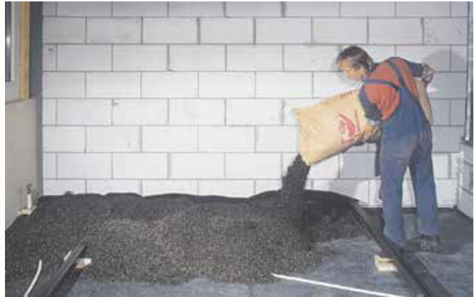
Schütten und verteilen, Mindesthöhe 20 mm.
