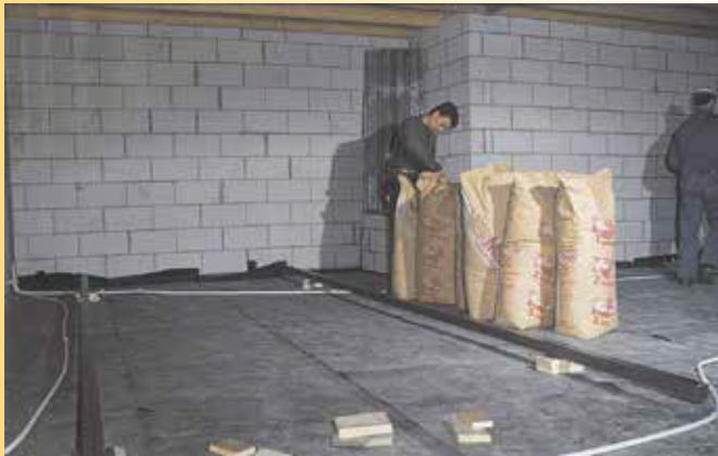
Setzen der Abziehlehen z. B. auf VERMIBIT.
