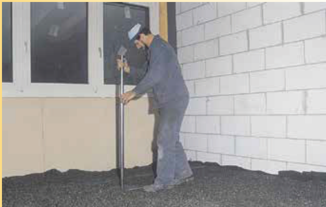
Verdichten der Schüttung ca. alle 4 cm, z. B. mit einem Rechen, Stampfer oder Brettschuhen um ca. 10 - 15%.
