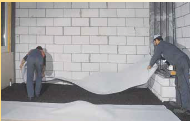
Wellkarton (oder für verbesserten Trittschall Weichfaserplatte 10 mm) verlegt, verhindert das Eindringen der Körner in die Fugen der Bodenverlegeplatten.
