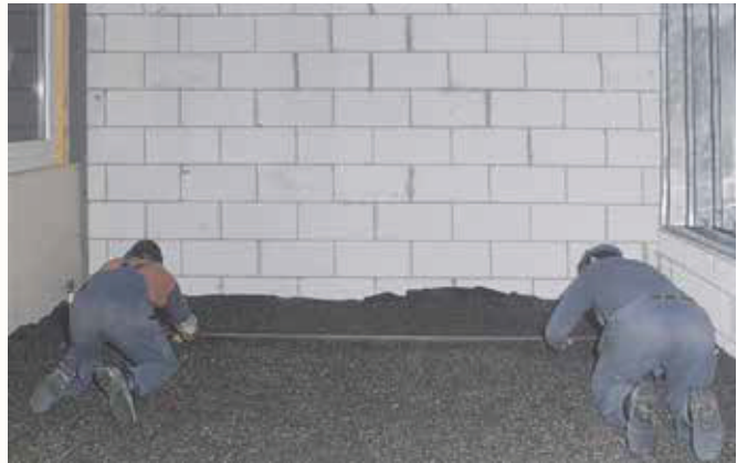
Oberflächenglattes Abziehen von VERMIBIT.
