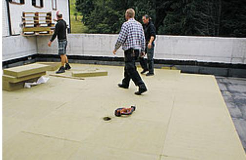
Trittfeste Dämmplatte für den Einsatz in Flachdächern, welche für eine Nutzung durch Personen und/oder für Installationen vorgesehen sind. Als Kerndämmung bei zweischaligen Betonwänden.
