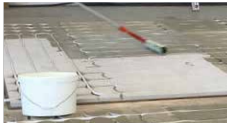
Grundieren mit Knauf Schnellgrund
