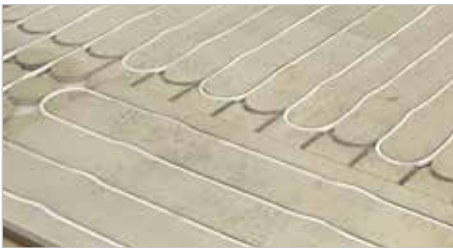
Rohrverlegung in Brio Heizboden 25
