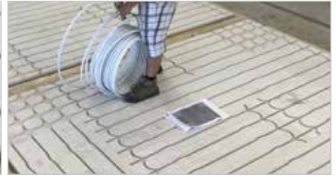
Rohrverlegung in Brio Heizboden 25
