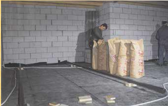
Setzen der Abziehlehren z. B. auf VERMIBIT.
