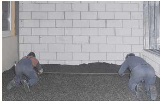
Oberflächenglattes Abziehen von VERMIBIT.
