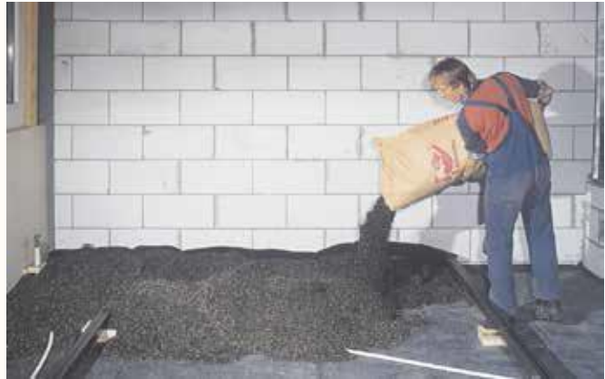
Schütten und verteilen, Mindesthöhe 20 mm.
